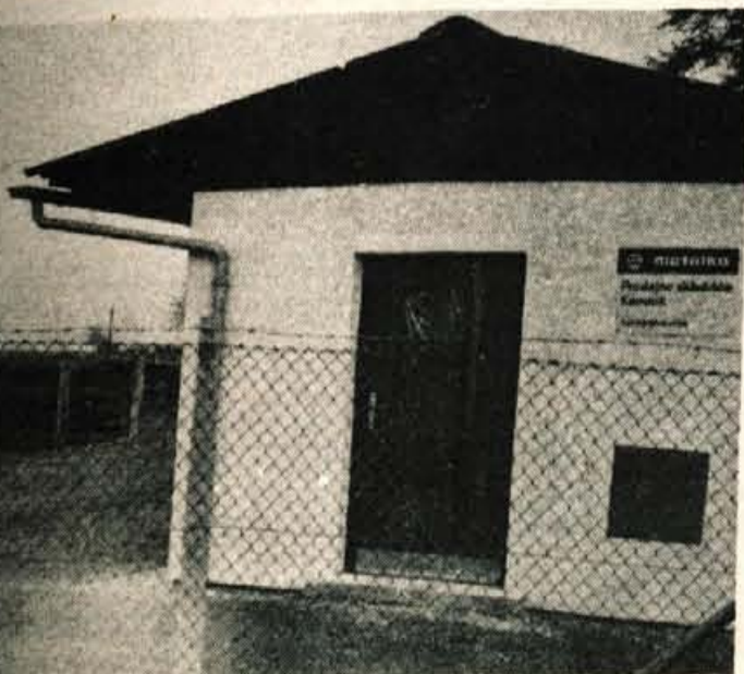
Novo skladišče kamniške METALKE na nekdanjem sejmišču
