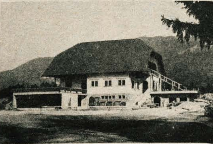
Gradnja na golf igrišču - Na golf igrišču na Bledu, ki je last Zavoda za pospeševanje in razvoj turizma Bled te dni obnavljajo restavracijo, ki jo bodo lepo in funkcionalno uredili ter tako pridobili več prenočitvenih zmogljivosti. Razen tega potekajo dela tudi na drugem objektu, ob koncu pa nameravajo urediti še okolico. Naložba je po predračunu vredna 30 milijonov 800.000 dinarjev. - Foto: D. Kuralt
