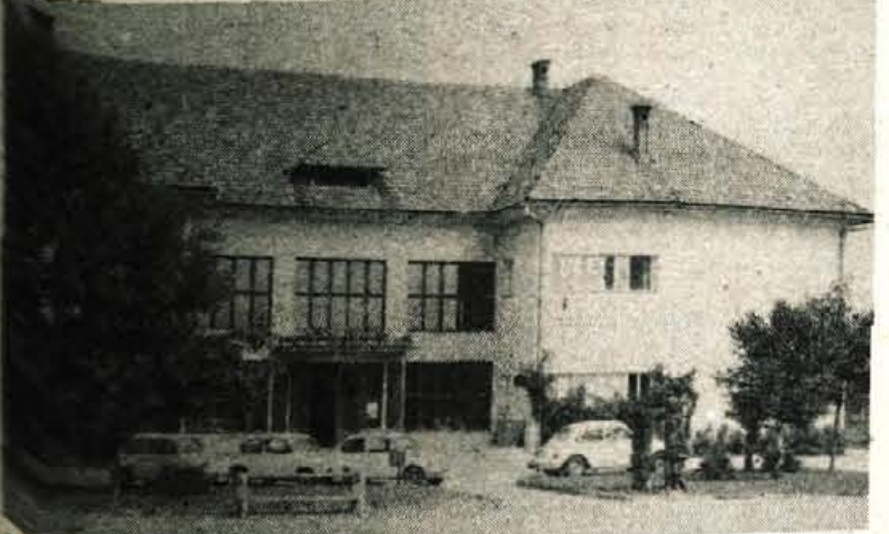
Mostah kliče po obnovi - Poslojpe osnovne šole v Mostah Komendi so zgradili udarniško po vojni. Kaže, da gradnja tedaj ni najboljša, saj poslojpe že kliče po temeljiti obnovi. Posebej opaziti strop v telovadnici, nad katerim so stanovanja. Zaradi nevarnosti, da se strop podre, so telovadnico zaprli, stanovalci pa se morali izseliti. Krajanje Most so se najprej zavzemali, da bi se stanovanja skupnost prevzela investicijo; zgradili bi novo telovadnico, da bi učenci uporabljali kot jedilnico, v njem pa bi ostal tudi prostor za predmete skupne vzgoje. Toda njihovo zavrnitev je zavrlo omejevanje investicij, saj je kamniška izobraževalna skupnost morala sredstva za naložbe zmanjšati z 8,36 milijonov na 2,5 milijonov dinarjev. Vse torej kaže, da bo moč poslojpe le obnoviti.
