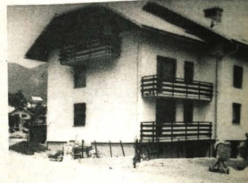
Gorje — V Spodnjih Gorjah so letošnje poletje dogradili nov stanovanjski blok, ki ga je gradilo SGP Bled-Grad. Izgradnjo bloka največ financiralo stanovanjsko podjetje Alpdom iz Radovljice, denarja pa je prišlo tudi od sklada pokojninskoinvalidskega zavarovanja občine Radovljica. Nekaj stanovanj je bilo odkupljenih, ostala pa najemniška. V začetku letošnjega avgusta je dobilo ključke deset tujih družin, med njimi tudi nekaj upokojskih. Svoje klubske prostornosti s sanitarijami so vendarle dobili tudi upokojski društva Gorje-Zas. Tako bodo imeli upokojski prostore za svojo dejavnost in družabna srečanja. — Foto: J. Ambrožič
