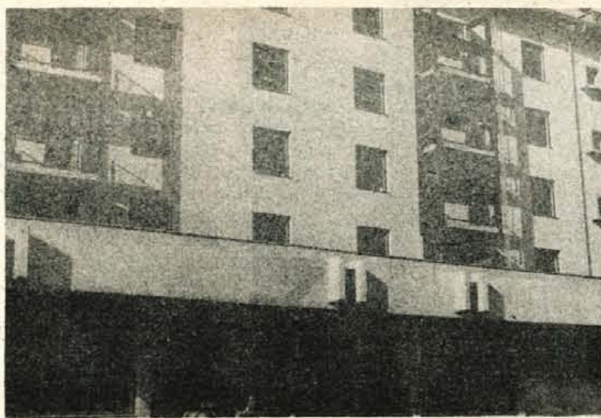
Vrtec iz samoprispevka - V novem stanovanjskem naselju v Preski gradijo delavci gradbenega podjetja Megrad vzgojnovarstveno ustanovo za 90 otrok. Objekt II. samoprispevka ljubljanskih občanov bo vrljal 12 milijonov dinarjev. vseljiv pa bo koncem leta. -fr
