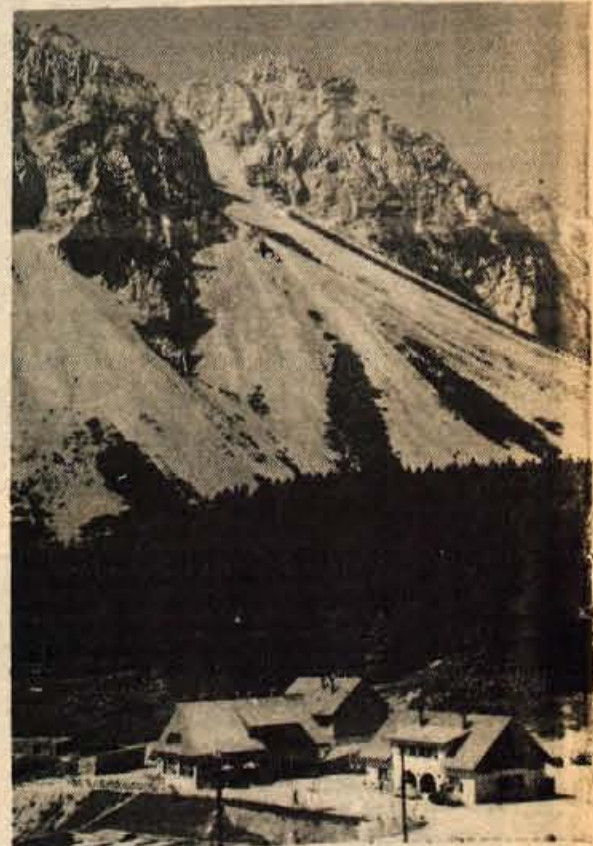
Pogled z obmejnega platoja pred ljubeljskim cestnim predorom na peskoviti plaz pod Begunjsčico
