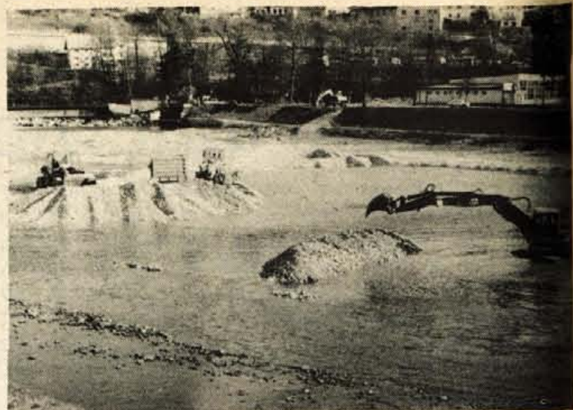
Trenutne ugodne vremenske ramere in nizka voda v strugi Save sta omogočila izkop in odvoz peska iz same struge. Vendar pa tokrat ne gre za navaden izkop. Območna vodna skupnost je pod Tekstilindusom v Kranju pričela s poizkusnim izkopom lovilne jame za potrebe bodoče hidroelektrarne Mavčiče. Da ne bi nanosi Save prehitro zamašili same centrale, naj bi lovilna jama prestregla to že dosti prej. Z deli na Savi se ubadajo delavci rečne nadzorne službe Vodnogospodarskega podjetja Kranj. — Foto: D. Dolenc
