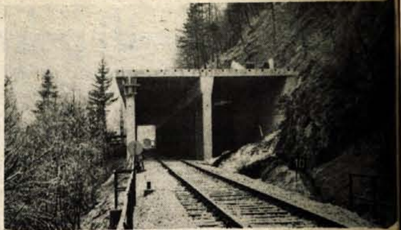
Soteska pri Nomnju — Železniško progo v Soteski so vedno zapeli snežni plazovi, zaradi tega pa je prihajalo do pogostih zamud vlakov. Vse nevarne dele proge nameravajo zavarovati in zato deluje železniškega gradbenega podjetja Ljubljana grade galerije, prek katerih bodo snežni plazovi zdrknili čez progo v Savo Bohinjko. Foto: B. B.
