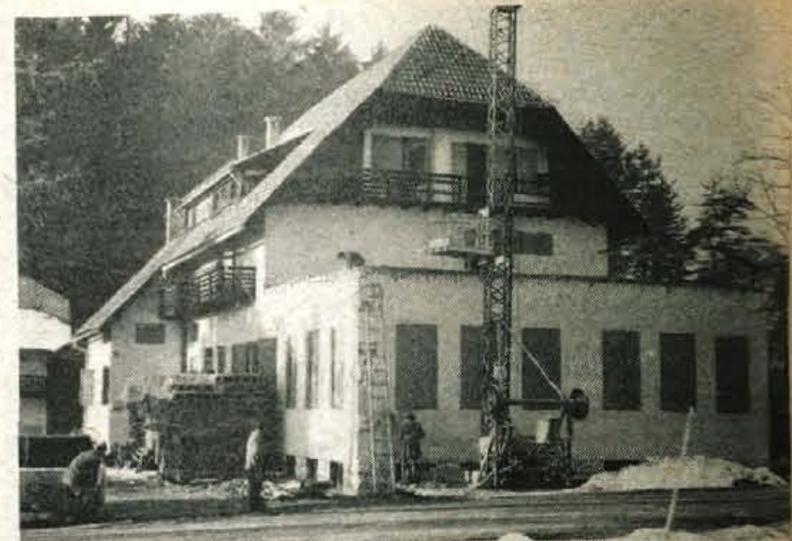
Radovljica - Delavci Splošnega gradbenega podjetja Gorenje iz Radovljice nadaljujejo z obnovitvenimi deli ali adaptacijo starega Standrovega doma v Radovljici. Dom bodo temeljito obnovili, dela pa so zahtevna in upajo, da bo potrebam sindikalnega izobraževanja namenjen že prihodnji pomlad. V Standrovem domu bo namreč sindikalni republiški izobraževalni center. - Foto: F. Perdan
