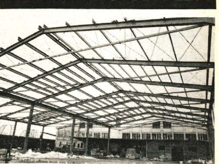
V škofjeloški Termiki gradijo pokrito skladišče za izolacijske materiale. — Foto: F. Perdan
