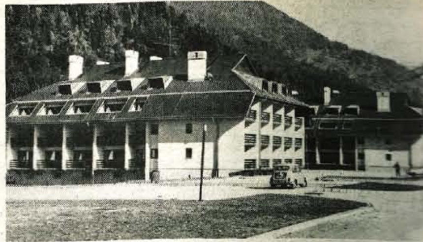
Nova počitniška stanovanja – V kranjskogorskem naselju Črtenj sta zrasla še dva nova bloka s počitniškimi stanovanji. Delavci Gradisa z Jesenic so v vsaki stavbi zgradili po 40 stanovanj, povečini garsonjer, ki jih bodo kupcem izročili do konca novembra letos. V bližini zidajo prav tak blok, katerega naj bi predali namenu sredi prihodnjega leta. (S) – Foto: F. Perdan
