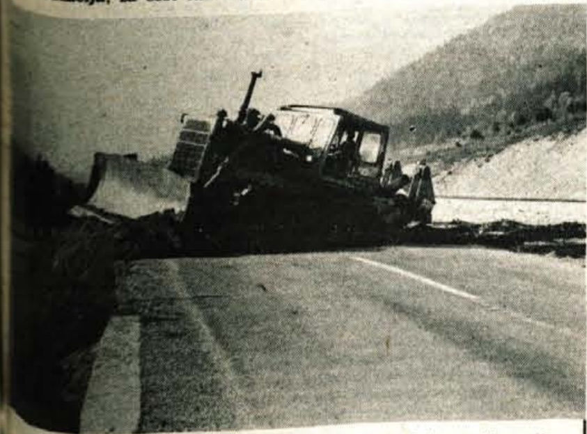
Priloge na izgradnjo predora — Skupina 35 delavcev Slovenija — Tehnika, temeljna organizacija Nizke gradnje, je pod strokovnim nadzorom inženirja Igorja Nagliča in vodstvom Rajmunda ... 21. oktobra začela rušiti odsek stare magistralne ceste, kjer bo ... načrtovani karavanski predor na Hrušici. V dobrem tednu dni ... naredila sedem metrov globok izkop za portal predora. Za ljubljansko ... delavci bodo na gradbišče prišli delavci zagrebške Geotehnike. ... izkop ogradi s pilotno steno iz armiranega betona. Na sliki: ... dela pri izkopu portala — Besedilo in slika: S. Saje
