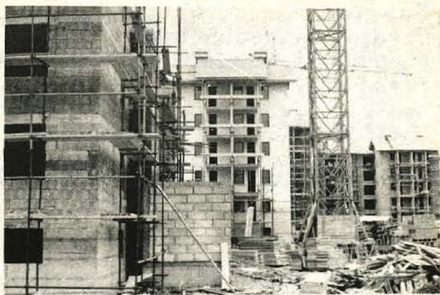
V Cankarjevem naselju v Radovljici poteka gradnja nove stanovanjske soseske po programu in brez zastojev - Foto: F. Perdan
