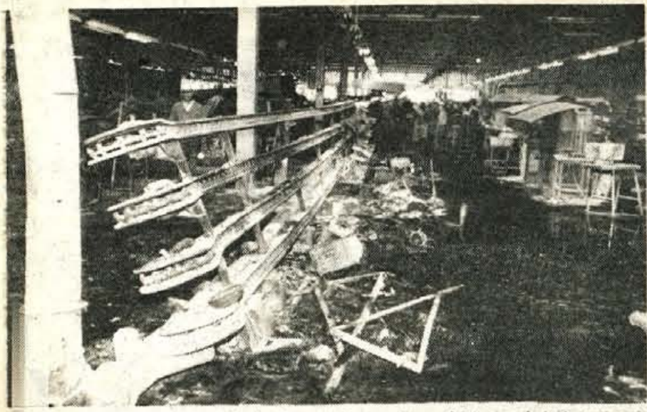
Za več milijonov škode je nastalo v požaru, ki je zgodaj zjutraj zajel montažno halo žirovske Alpine. Zaradi učinkovitega posredovanja gasilcev, ogenj kmalu pogašen. — Foto: Kun
