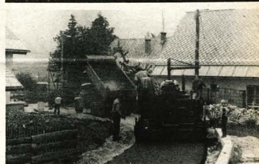
Rateče — Pred nedavnim je kranjsko cestno podjetje asfaltiralo poti po Ratečah. Tako so zdaj v tem kraju vse poti asfaltne, vendar bi bila glavna cesta skozi Rateče potrebna obnove. Asfaltiranje je financirala rateška krajevna skupnost, del denarja pa so prispevali tudi krajanje sami. — A. Kerštan
