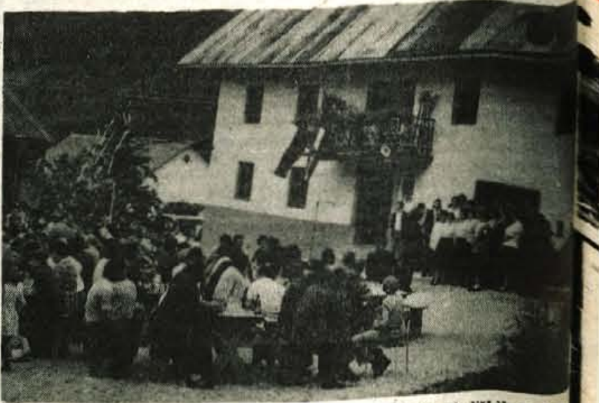
Pri »Stihlnus« v Lajšah so se zbrali krajani Selca in okoliških vasi na proslavi svojega krajevnega praznika. Tokrat so praznovali tudi veliko delovno zmago: asfalt so potegnili od Selca skoraj do samih Lajš. — Foto: D. Dolenc
