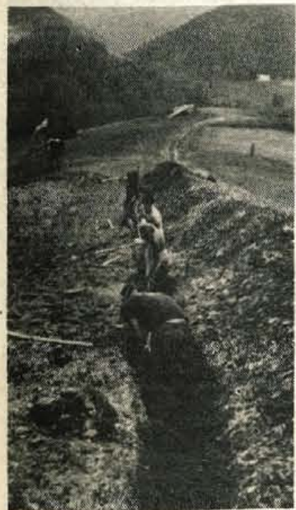
Mladi Škofjeločani pri izkopavanju vodovodnega omrežja visoko na pobočjih.
