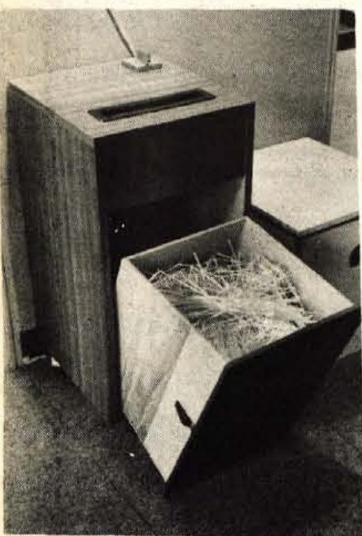
NAPRAVA ZA UNIČEVANJE DOKUMENTACIJE razreže za minuto do 7,5 kvadratnega metra dokumentov ali 100 listov velikosti A4
