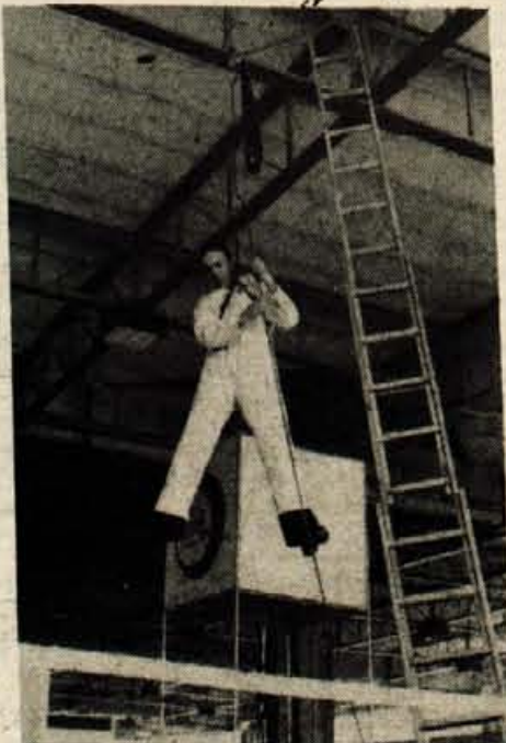
»Reševalni komplet« izdeluje SOZD Astra, DO IPI Jesenice v sodelovanju s francosko firmo Komet. Uporablja se za reševanje ponesrečencev iz visokih stavb, žerjavov, gondol, žičnic itd. V kompletu so naprave za zaporedno reševanje štirih, na zahtevo kupca pa tudi več oseb. Uporaba je enostavna. Nudijo tudi napravo istega proizvajalca za varovanje delavcev pri delu v višinah. Na sliki je ponesrečenec v ognjevarni obleki. Informacije o omenjenem kompletu so vam na voljo v Astru Ljubljana, oddelek zaščite, tel. 320-758.
