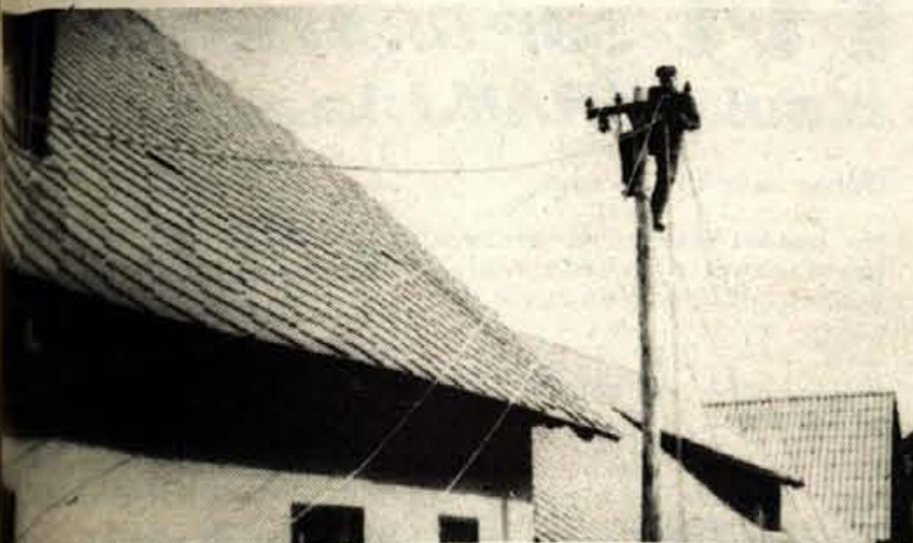
Priljubljena pri Gorjah Delavci Elektro podjetja iz Žirovnice, enote Bleda so februarja in marca obnovili vse elektrovođe. Nekateri delavci so obnovili še glavni vod do samih stanovanjskih hiš in bo vsaj dovod elektrike po tej vasi brez večjih zastojev. Vodi so novi in sodnejši. - Foto: J. Ambrožič
