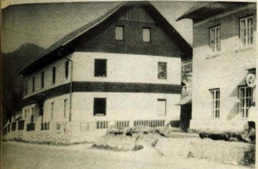
V Gorjah so poskrbeli za varstvo najmlajših, saj so preuredili prostor. V njem so štirje veliki in preurejeni prostori, stavba pa lahko sprejme 110 otrok. Obnovili so tudi kuhinjo, garderobne in sanitarne prostore. Gradbena dela je opravilo Gradbeno podjetje Bohinj, pleharska dela pa Splošno obrtno podjetje Bled-Grad z Bleda. — Foto: Ambrožič
