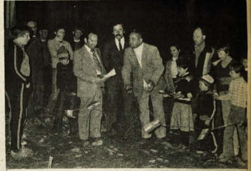
Kranj - Na predvečer 1. maja so v krajevni skupnosti Čirče slovesno izročili namenu novo balnišče in otroško igrišče, ki so ju zgradili sami. Okrog 850 prostovoljnih delovnih ur so naredili, krajevna skupnost je prispevala 7.500 dinarjev, krajani pa so s prostovoljnimi prispevki zbrali 16.260 dinarjev. 2.000 dinarjev so primaknile tudi delovne organizacije na njihovem terenu. Objekta bodo še dograjevali. Imajo pa v tej krajevni skupnosti še velike načrte: izgradnjo večnamenskega družbenega doma. Odkupili so že zemljišče in pripravljajo gradbeno načrte in vsa potrebna dokumentacija. Leta 1981 bodo predvidoma že začeli z gradnjo. Krajani so pripravjeni, da bodo tudi pri družbenem domu pripomogli po vseh svojih močeh. - Foto: F. Perdan
