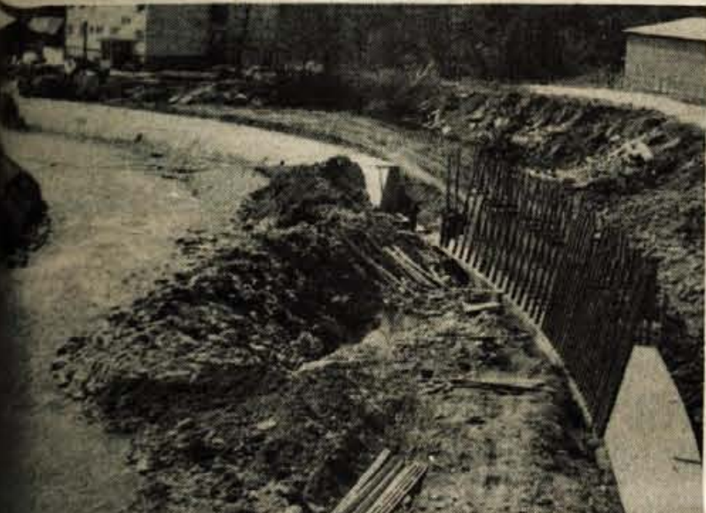
Sanacija Trziške Bistrice - Območna vodna skupnost Gorenjske odločila, da dá ob Trziški Bistrici zgraditi 160 metrov opornih stien, ki bodo muhasti reki preprečili spodkopavanje obrežja. Do tega trenutka je bilo večkrat, najhuje pa je bilo po lanski januarski povodnji. Priljubljeno tako je tudi razmerje med kupci; skoraj polovico stanovanj so odkupili etažni lastniki, ostala pa delovne organizacije in stanovanjska skupnost. (H. J.) - Foto: F. Perdan
