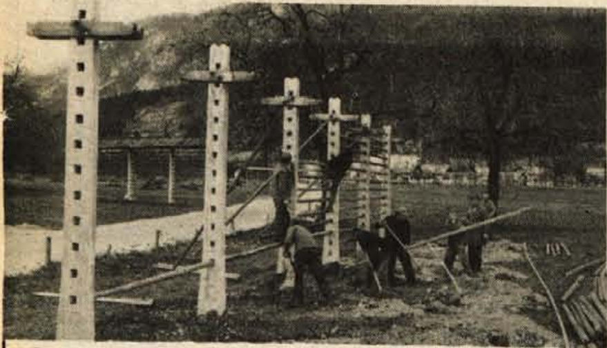
Begunje – Prejšnji petek se je skupina Elanovih delavcev trudila z zanje dokaj nenavadnim delom: v bližini tovarne so postavljali kozolec. Elan se namreč širi proti severu in ima tam že dalj časa po urbaniščenem načrtu rezervat za svoje nove investicije. Nova zemljišča potrebuje za nova skladišča lesa in telovadnega orodja. Pa je na tem zemljišču stal tudi velik Stavarjev kozolec, ki ga je bilo po pogodbi treba prestaviti na drugo Stavarjevo zemljišče. Pogodba je pogodba in treba jo je spoštovati. Zato so Elanovi delavci zavihali rokave in se ga lotili. Pa jim je šlo delo kar dobro od rok. – Foto: D. Dolenc
