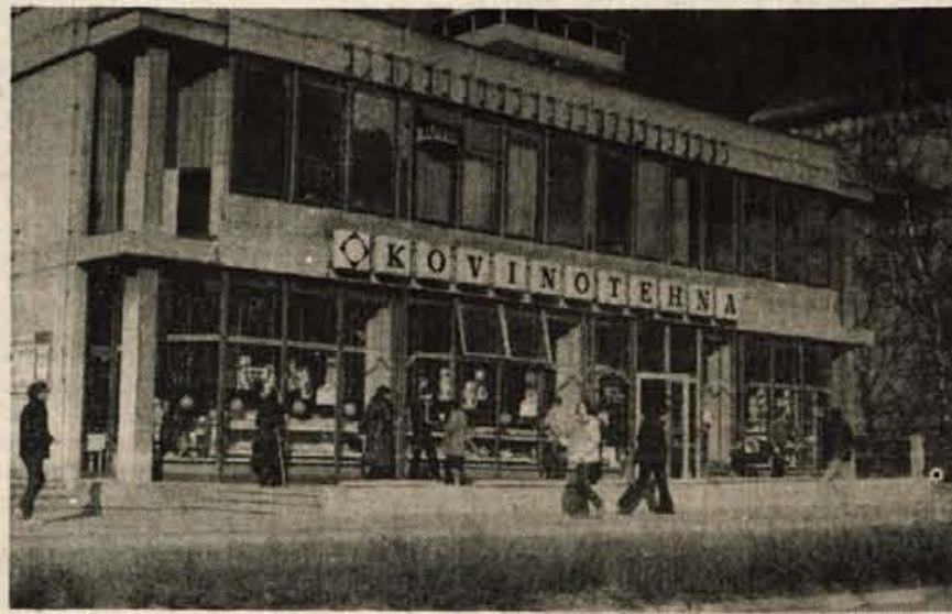
Trgovine z železino, gradbenim materialom in podobnim morajo imeti zadosti velik prostor za nakladanje, razkladanje in parkiranje. Kovinotehna ŽELEZNINA na Jesenicah pa je vse preveč utesnjena in nujna je zanjo nova lokacija.
