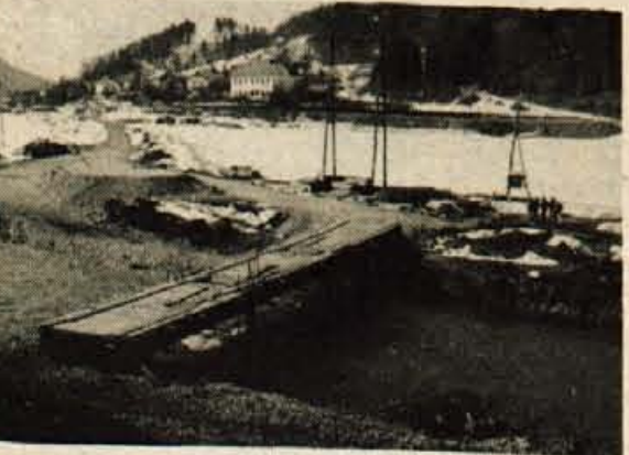
Vasici se je že približala trasa suranske ceste, ki bo z novim mostom prečkala Soro. Drugi most tudi že pripravljajo, na polju pa je polno količkov, ki bodo usmerjali gradnjo nove prometnice skozi Poljansko dolino.
