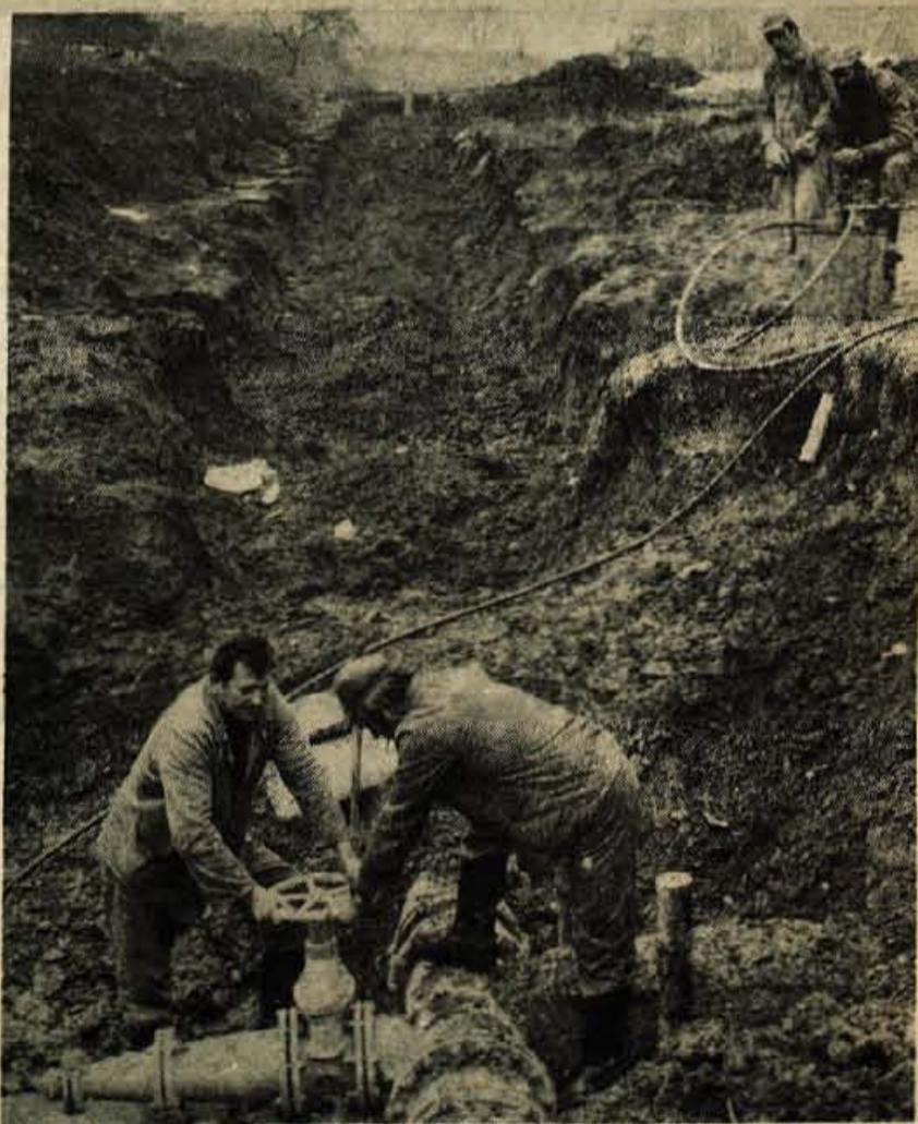
Delavci Tehnika so morali pred začetkom gradnje ceste prestaviti vodovod na Dolgih travnikih.
