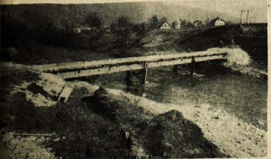
Kjer je sedaj zasilna brv bodo čez leto delavci Gradisa postavili nov most med Gabrkom in Brodmi.
