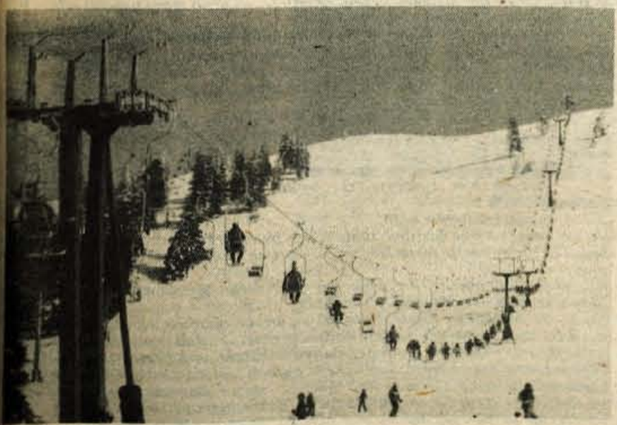
Na zahtevo Zavoda za raziskavo materiala so na Krvavcu morali sanirati trinajst let staro žičnico, ki pelje do Doma. Od prejšnjih 400 oseb na uro prenovljena žičnica sedaj popelje do Doma 900 smučarjev na uro.
