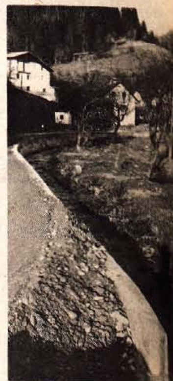
Za preureditev ceste od Ševlje do Bukovščice je bilo treba zgraditi tudi škarpo nad potokom. Ne le da cesto obnavljajo s prostovoljnimi dinarjem, krajanje so sami pripeli do dela in dali na razpolago svojo mehanizacijo.
