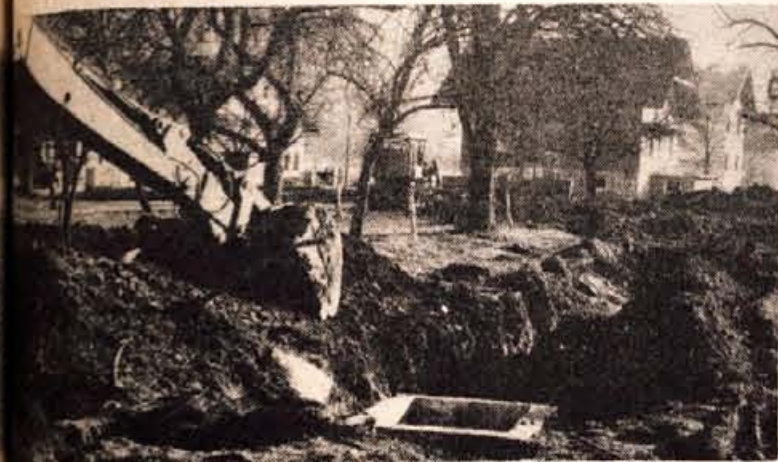
VOVOD IN KANALIZACIJA V DUPLJAH — Duplje so že nekaj časa gradbovščice. Krajanje so se lotili urejevanja kanalizacije, ki bo odstranila poplav ob večjih nalivih in daljšem deževju, prav tako pa tudi omrežje električno omrežje. Hkrati s tem pa prebivalci Žej povečujejo električno napeljava. — Foto: F. Perdan
