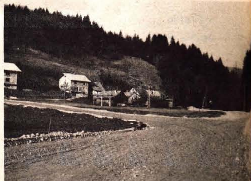
Če ne bi videli, ne bi verjeli, kako obsežnega dela so se lotili krajanje. Naštetih štiri kilometre dolgo cesto od Ševlje do Bukovščice je širok več kot pet metrov. Nanj bodo prihodnje leto položili prvo plast asfalta.
