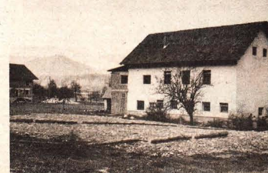
Športno igrišče na Bukovici je tik pred asfaltiranjem. Treba ga bo še opremiti.
