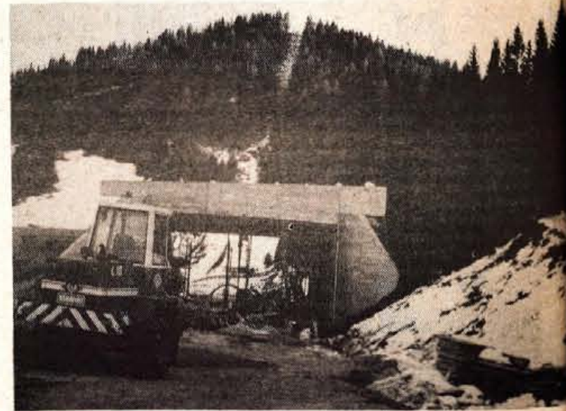
Gradbena dela novega zatrniškega smučarskega nadvoza – ta je že tretje vrsti – so zaključena, le material za položno speljano smučišče pod njim še treba navoziti. Te dni bodo vsa dela gotova in Zatrnik bo pripravljen na snežno odejo in veselo smučarje. – Foto: D. Dolenc
