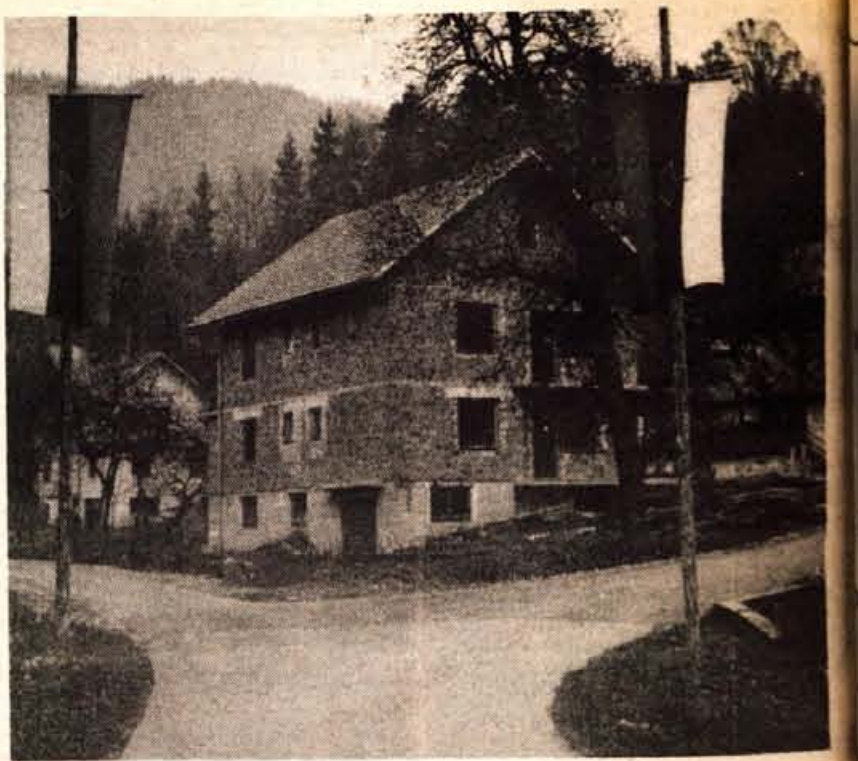
Del na novo asfaltirane ceste v Češnjevku – Foto: F. Perdan
