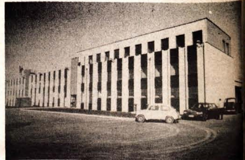
Nova proizvodna dvorana temeljne organizacije za proizvodnjo kmetijske mehanizacije na Primskovem — Foto: F. Pedran
