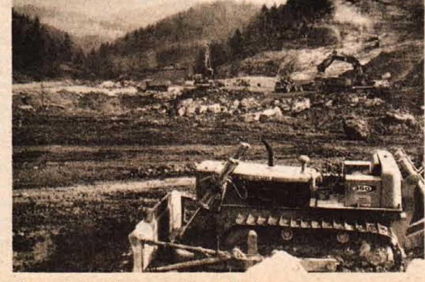
Pri izgradnji rudnika in ceste dela več sto delavcev.
