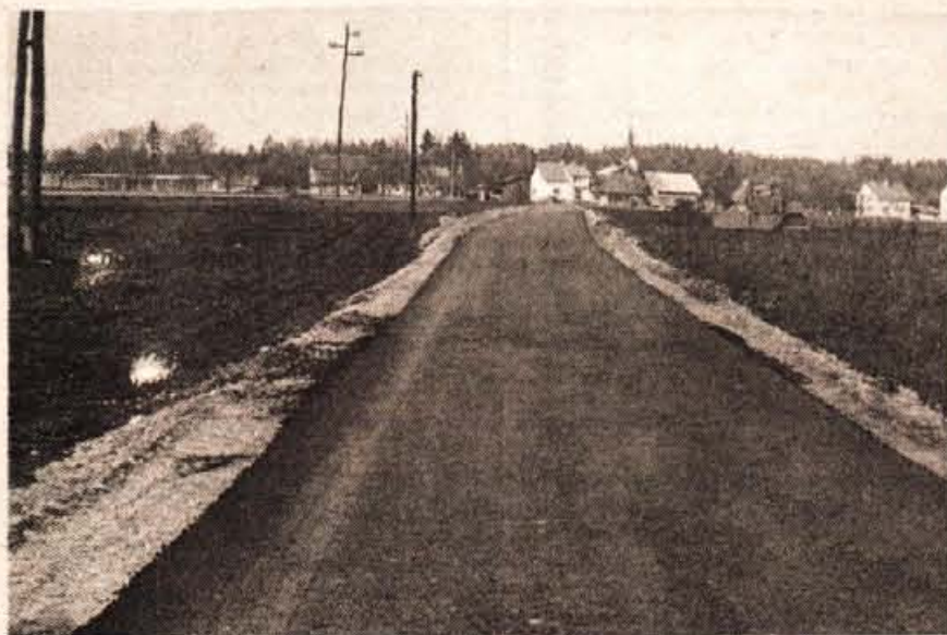
ASFALT DO DOLA - Cesta Sora - Dol je končno dobila asfaltno prevleko, s tem pa so bile tudi izpolnjene obljube vaščanom 13 hiš v Dola. Vaščani so tudi sami veliko prispevali v denarju, s prostovoljnimi delom ali z odstopom zemljišča, preostanek denarja, nekaj nad milijon dinarjev, pa je prispevala Komunalna skupnost občine Ljubljana - Šiška. - fr
