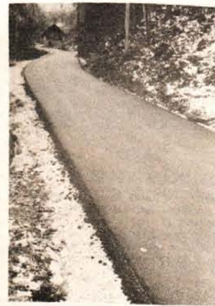
Ceste proti Martinj vrhu, Ojstrem vrhu in Podlonku so dobile letos asfaltno prevleko.
