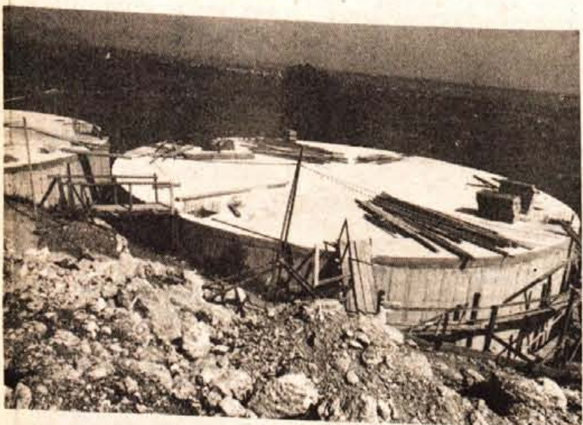
SKOFJA LOKA — Da bi bilo vode v vseh letnih časih dovolj, gradi Splošno gradbeno podjetje Tehnik iz Skofje Loke na Kamnitniku nov vodni rezervoar. Gradijo ga delavci temeljne organizacije Grandje, financira pa ga temeljna organizacija Komunala. Nov rezervoar je potreben, ker se je poraba vode v Skofji Loki v zadnjih letih močno povečala. Mesto se namreč hitro razvija, saj rastejo nova naselja na vseh koncih. — Foto: F. Pedan
