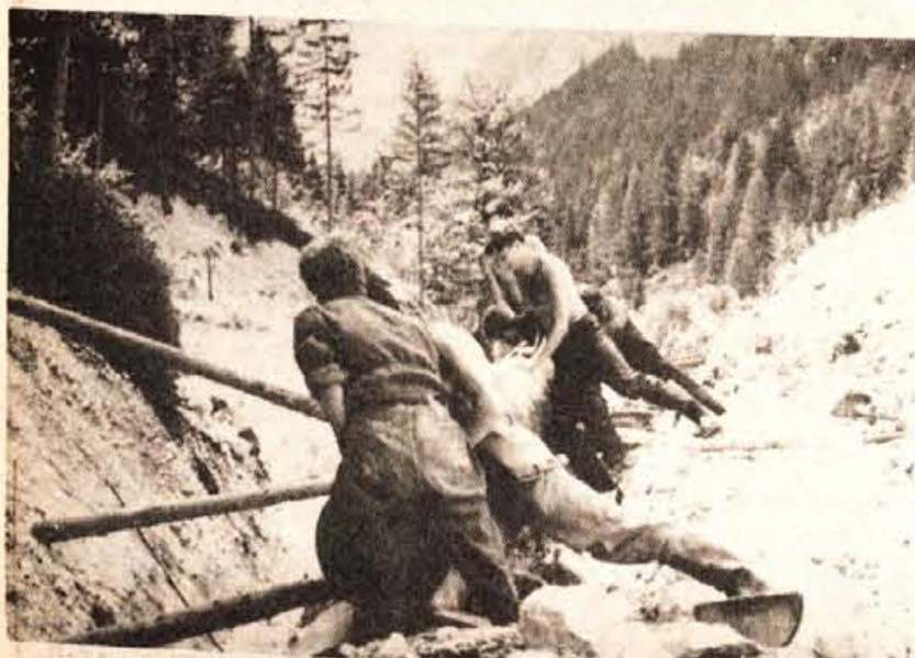
Dela pri izgradnji vodovoda od Peričnika do Jesenic so bila nad vse zahtevna.
