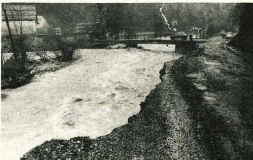
Kokra neusmiljeno zajeda v obrežje in spodkopuje že tako slabo cesto proti Jezerskemu. Most pri Povšnarju komaj še sprejema deročo vodo. Nekateri leseni mostovi pa so že popustili.
