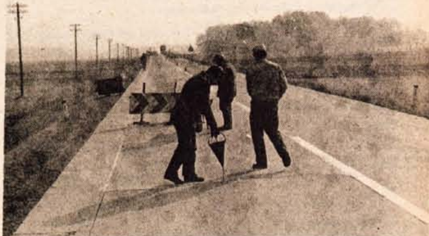
ZALIVANJE RAZPOK — Da bi preprečili večje poškodbe na cesti I. reda Kranj—Ljubljana zaradi zmrzali, te dni delavci Cestnega podjetja Kranj zalivajo razpoke med betonskimi bloki z vročo smolo. Obenem bodo s tem tudi izboljšali vozno površino. (—fr)
