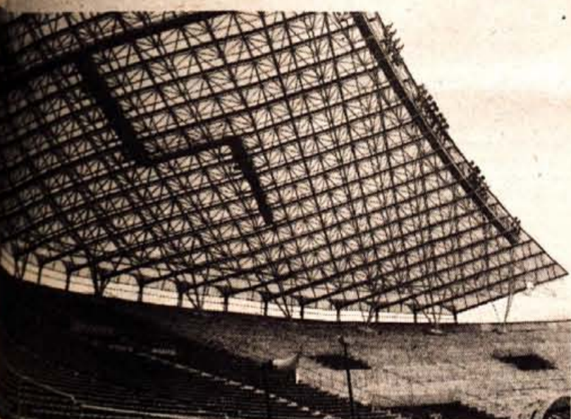
...mestnega stadiona se je že med gradnjo prijelo ime »Poljudska ... Pa ga tudi resnično zasluži. Nadvse uspela arhitektonska rešitev ... Borisa Magaša je in morda še ne veste, da so montažo te zahtevne in ... konstrukcije opravili delavci in projektanti Termike. Oranžni ... ki dajo stadionu še poseben mik in privlačnost, pa so iz Mebla. ... sprejme 50.000 gledalcev in polovica jih je pod streho.
