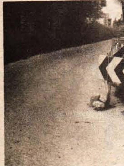
GORJE — Lani septembra se je odtrgal zemeljski plaz na Fortuni, tik poleg križišča cest Vintgar—Poljane—Jesenice.
