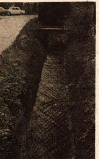
Kanalizacija v Sebenjah in Žiganji vasi je speljana kar po površini zemlje, zato ni čudno, da posebno ob nizkem zračnem pritisku iz jarka neprijetno udara.
