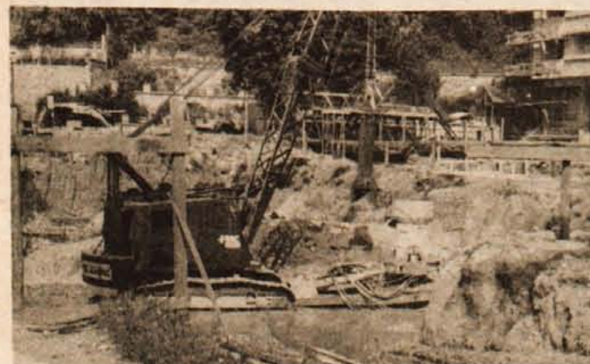
Jesenice — Pri izgradnji tretje stolpnice v stanovanjskem Centru II na Plavžu so naleteli na slabo nosilen teren. Zato bodo delavci ljubljanskega geološkega zavoda zgradili posebne nosilne pilote za stavbo. Izkop za pilote opravljajo s pomočjo posebnega samohodnega stroja. — B. B.
