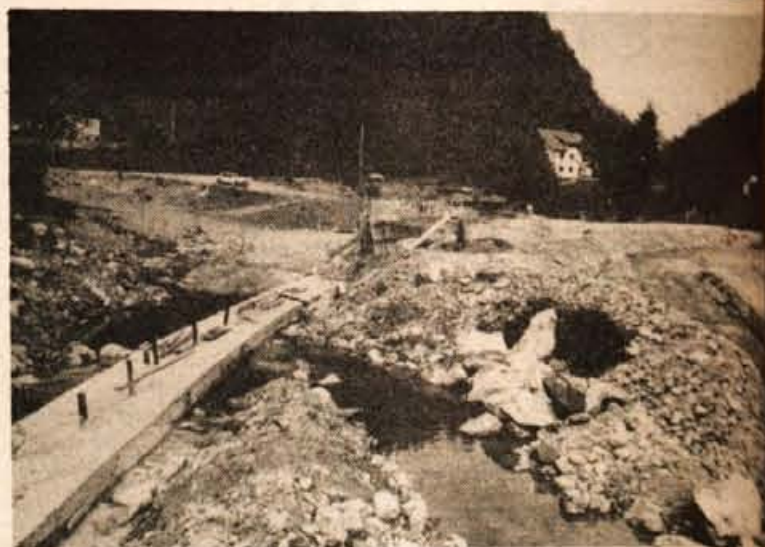
Vodnogospodarsko podjetje iz Kranja gradi oporni zid ob desnem bregu Kokre. — Foto: Perdan
