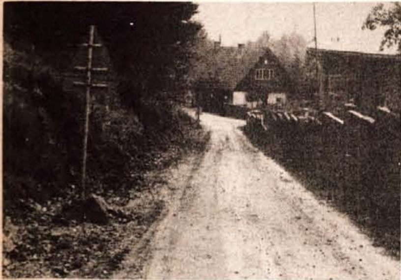
Mojstrana — Pred kratkim je Cestno podjetje iz Kranja začelo obnavljati in liti cesto od Mojstrane do slapa Peričnika. Obenem bodo rekonstruirali nepregledne ovine in strme klanke, tako da bo na obnovljeni cesti promet potekal bolj varno. To je tudi potrebno, saj dolino pod Triglavom obišče vedno več motoriziranih turistov in planincev, od Mojstrane do Aljažvega doma v Vratih pa vozi tudi avtobus. Ko bodo končali z deli na cesti do Peričnika, bodo začeli obnavljati odsek do Aljažvega doma. — A. Kerštan
