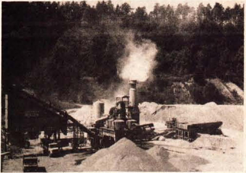
Naklo — Asfaltna baza v Naklem je v začetku avgusta dosegla lep delovni uspeh, saj so proizvedli milijon ton asfalta. Preden pa bo redno začela obratovati nova asfaltna baza z večjo zmogljivostjo v Podbrezjah, bodo kamioni iz sedanje dotrajane baze odpeljali še marsikatero tono asfaltno mešanico. — Foto: F. Perdan
