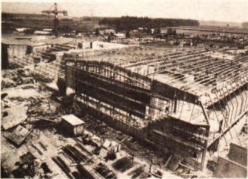
Kranj — Dela na novi osnovni šoli na Planini dobro napredujejo, saj je stavba, ki jo gradi SGP Gradbinec, že dobila tudi streho. Ob šoli za 750 učencev se gradi tudi športna dvorana z bazenom. — Foto: F. Perdan
