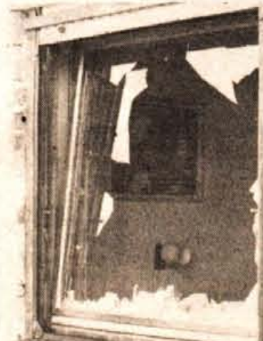
Premočno trkanje – Kot s kamni razbito steklo: pod ledom se je v krajih pod Krvavcem sesulo marsikatero steklo. – Foto: F. Perdan
