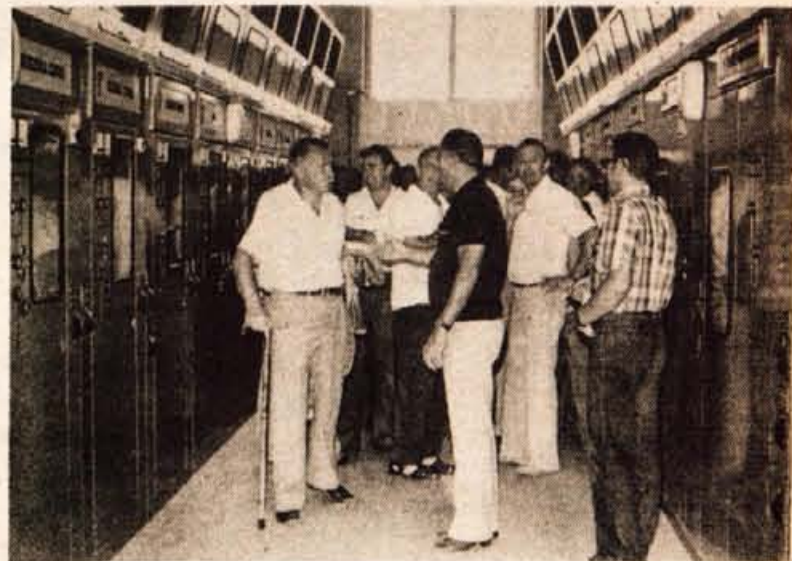
Predsednik izvršnega sveta skupščine občine Kranj inž. Drago Stefe je v sredo dopoldne v počastitev občinskega praznika prerezal trak nove razdelilne transformatorske postaje Primskovo. S tem je bila končana sicer šele prva etapa, saj bo treba v prihodnjih letih dograditi še transformacijo. Za novo razdelilno postajo na Primskovem se je bilo treba odločiti zaradi novih močnih odjemalcev električne energije, kot so komunalna cona in pa stanovanjski kompleks na vzhodni strani mesta, prav tako pa tudi tovarna IBI, RTC Krvavec in nova naselja severno od Kranja. Z novo postajo bo tudi letališče Brnik dobilo s posebnim kablom lasten in tudi kvalitetnejši dovod električne energije. Nova razdelilna postaja je veljala 32 milijonov din. Gradbena dela je opravilo SGP Gradbincev Kranj, elektromontažna dela pa Elektro Kranj. Postaja poskusno obratuje in so vse naprave že pod napetostjo. Investitor je bila delovna skupnost Elektro Gorenjska. — Foto: F. Perdan
