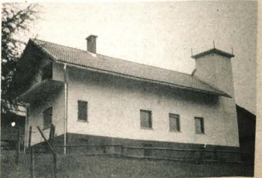
V obnovo gasilskega doma so krajanje Planine pod Golico lani in predlani vložili prek tri tisoč ur prostovoljnega dela.
