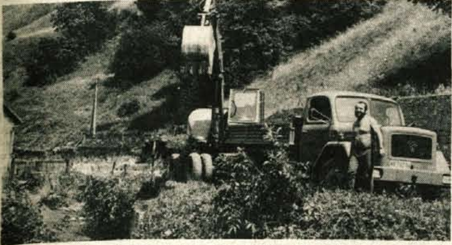
Širjenje ceste — Delavci tržiškega komunalnega podjetja širijo odcep ceste od Proletarske do klavnice, dolg približno 300 metrov. Cesta bo po novem široka dobre tri metre, razen utrjevanja cestišča in polaganje asfalta pa bodo morali prej zabetonirati še obrežne zidove. — H. Jelovčan
