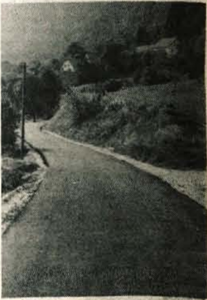
Partizanska cesta pravijo cesti med Jamnikom in Dražgošami. Pred dnevi so slovenski cestarji ob pomoči Dražgošanov vgradili skoraj kilometer asfalta na tej cesti.
