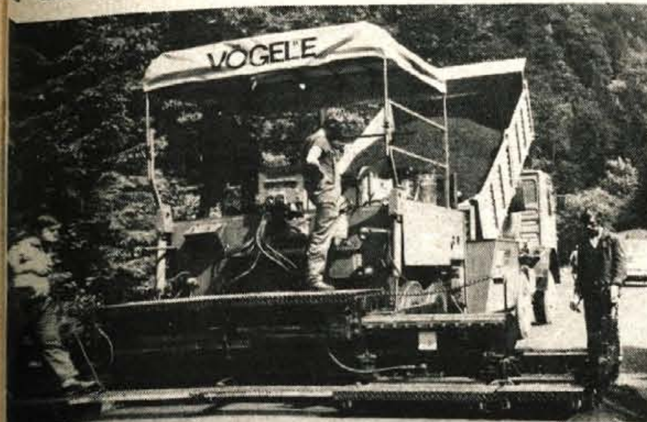
Naj sodobnejši finišer omogoča hidraulično reguliranje širine vozišča od 2,5 do 4,75 metra. Njegova dnevna zmogljivost je 1500 kubičnih metrov.
