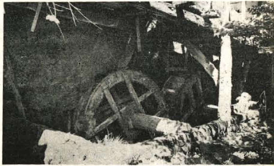
Voda ne priteka iz rak na mlinska kolesa — zdaj že razsušena, neuporabna.
