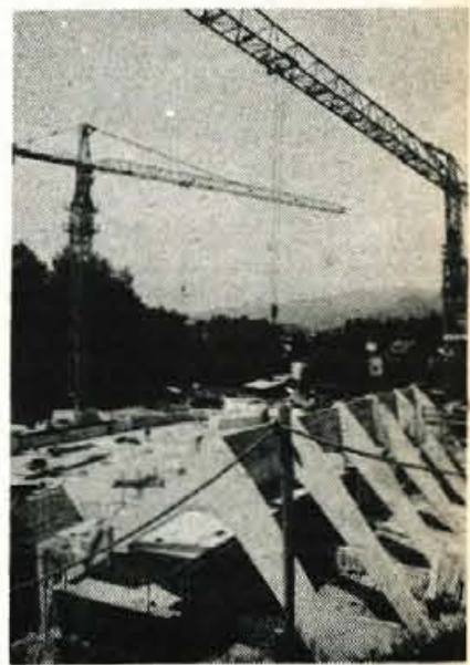
Bled — Po precejšnjih prizadevanjih turističnih in drugih delavcev na Bledu so sklenili samoupravni sporazum o financiranju strehe nad drsališčem. Splošno gradbeno podjetje Gradis je že začelo z deli; upajo, da bo blejsko drsališče dobilo streho pred začetkom svetovnega prvenstva v veslanju. — Foto: F. Perdan
