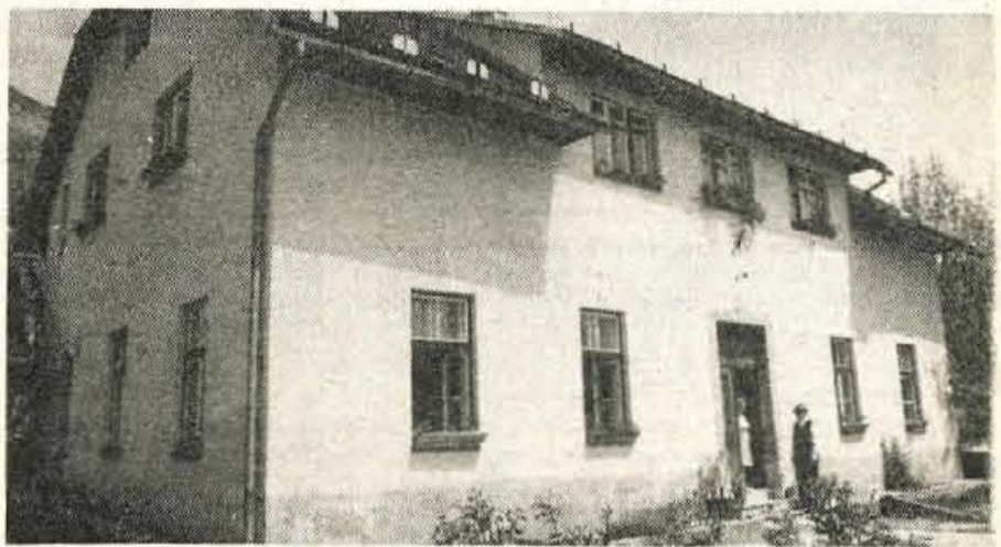
Obnovljena šola v Lešah (prvotna stavba je bila zgrajena že v letu 1895)
