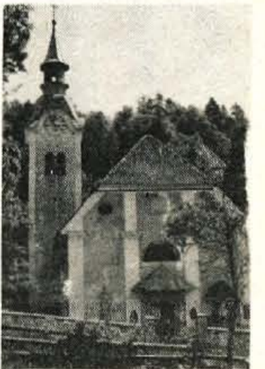
Farna cerkev v Lešah, viden je portal iz zelenega peraskega kamna, zavarovan s pristreškom. - Kot vse Leše, je tudi njihova cerkev vsa obdana z gostim zelenjem.
