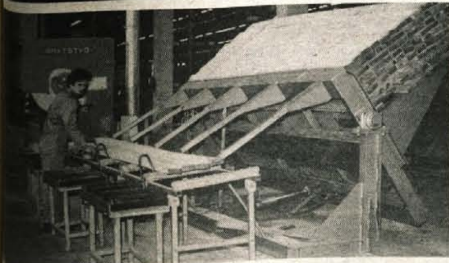
Novo tovarna montažnih hiš predstavlja za Jelovico prehod na industrijski proizvodnjo. S tekočega traku bo prišlo letno 1000 montažnih hiš, kar je več kot doslej. — Foto: F. Perdan
