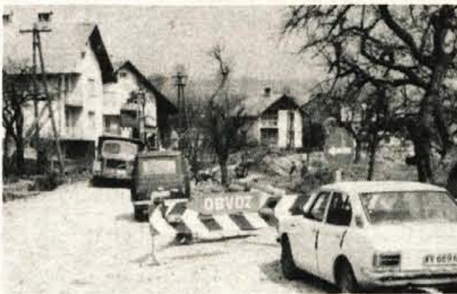
Zasip – Ker sta se naselja Rečica in Zasip v zadnjih letih precej povečala, je postala stara cesta preozka in preveč nevarna. Delavci obrtnega gradbenega podjetja Grad Bled jo širijo od mostu čez potok Rečica v smeri proti Zasipu. Pozneje jo bodo delavci Cestnega podjetja Kranj še asfaltirali. – Foto: B. B.
