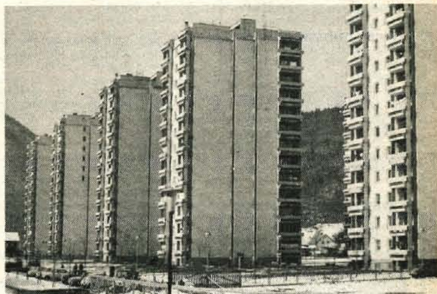
V Podlubniku so lani zgradili dve stolpnici. Za letos je plan enak. — Foto: F. Perdan
