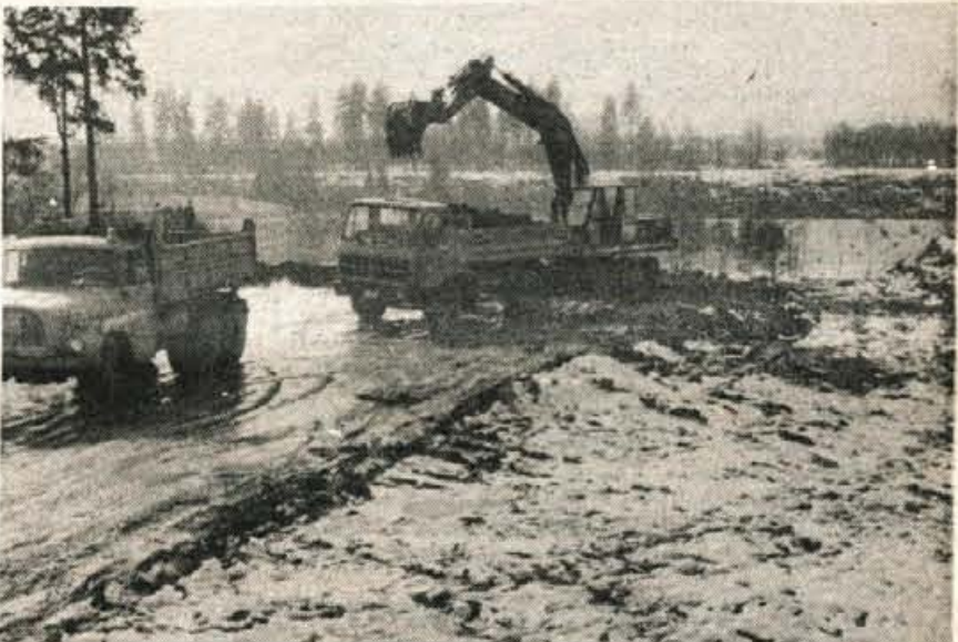
Gradbišče novega mostu čez Savo nad Planiko v Kranju. Most je prva faza uresničevanja desetletnega programa razvoja cestnega omrežja v kranjski občini. — Foto: F. Perdan
